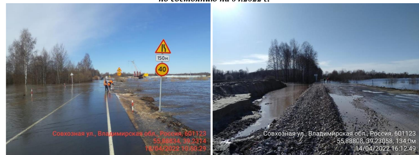
Фото участка дороги по состоянию на 04.2022 г.
