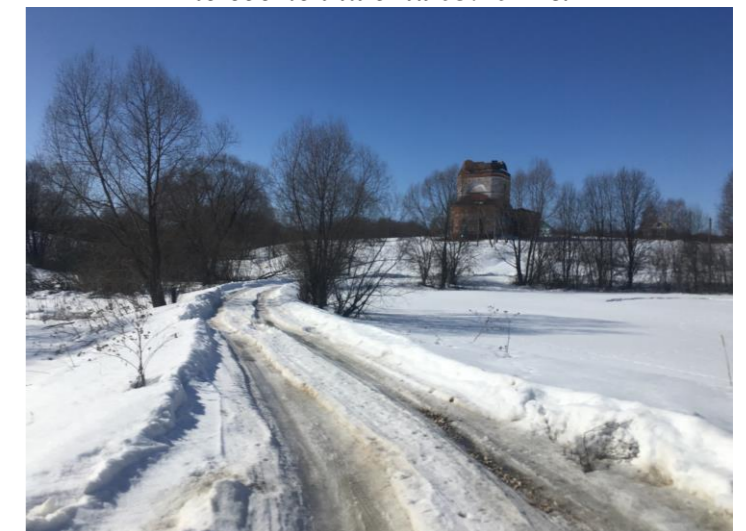
Фото участка дороги №3 по состоянию на 03.2022 г.
