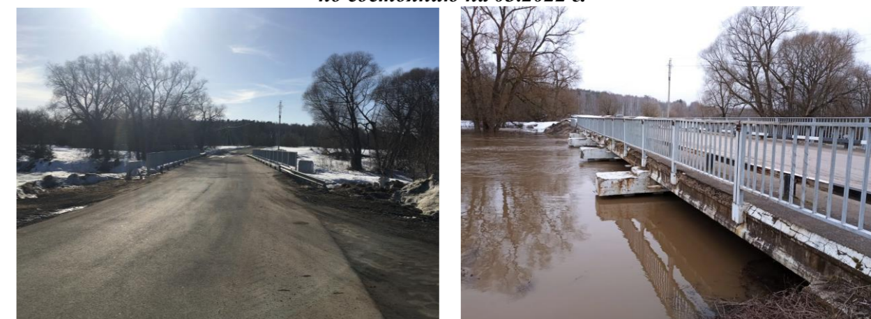
Фото участка дороги по состоянию на 03.2022 г.
