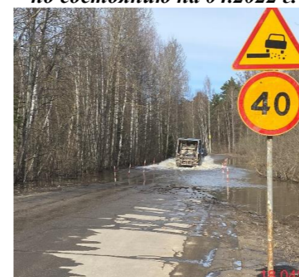
Фото участка дороги № 2 по состоянию на 04.2022 г.
