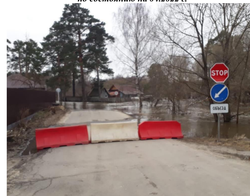
Фото участка дороги по состоянию на 04.2022 г.
