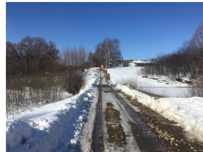
Фото участка дороги №2 по состоянию на 03.2022 г.
