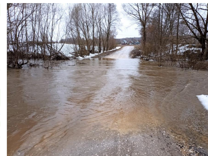
Фото участка дороги по состоянию на 04.2022 г.
