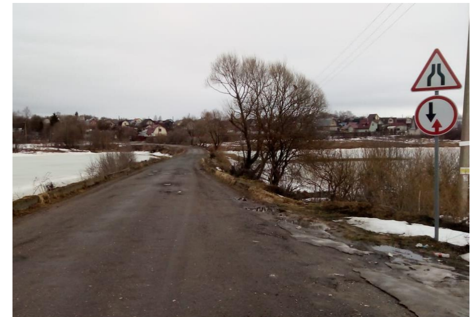
Фото участка дороги по состоянию на 04.2022 г.
