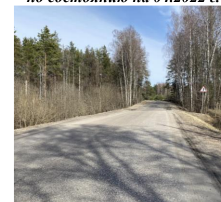
Фото участка дороги № 4 по состоянию на 04.2022 г.
