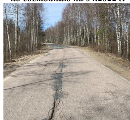
Фото участка дороги № 1 по состоянию на 04.2022 г.
