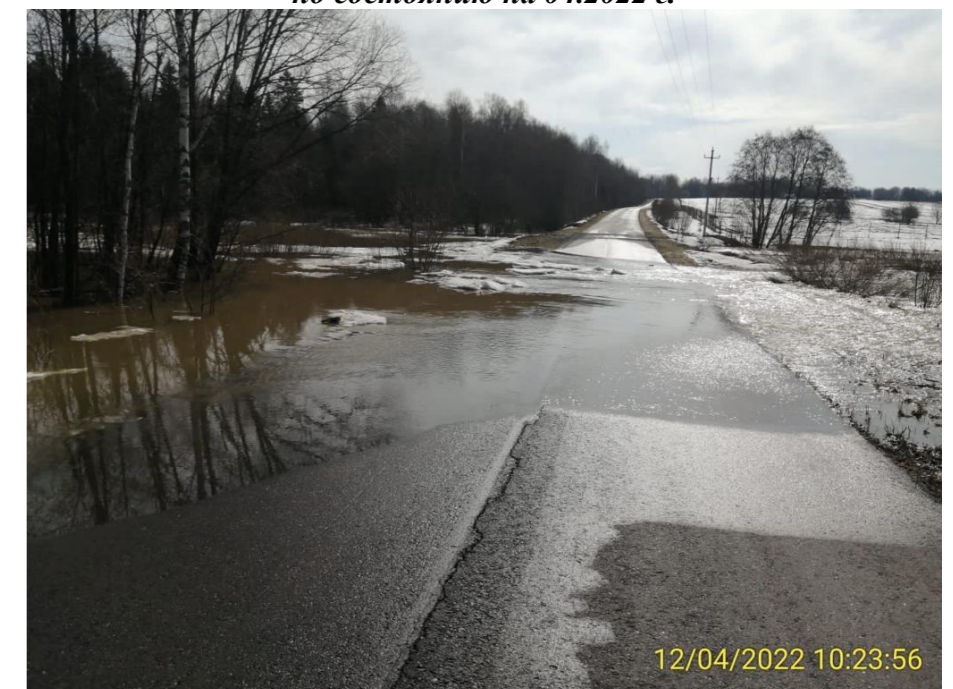
Фото участка дороги по состоянию на 04.2022 г.
