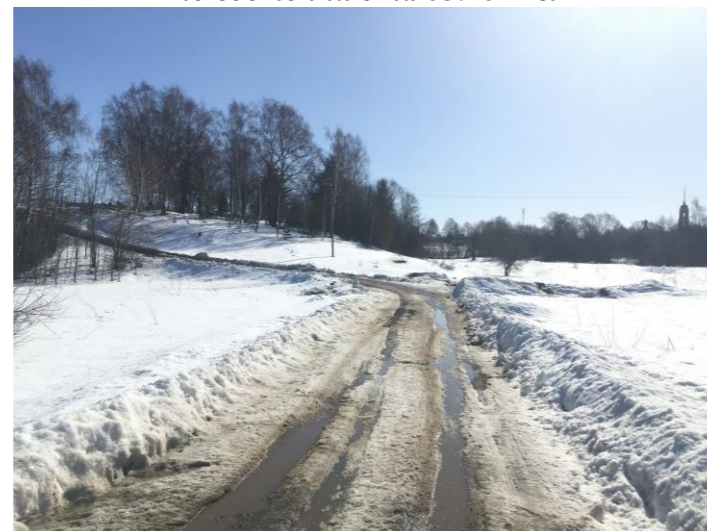
Фото участка дороги №1 по состоянию на 03.2022 г.
