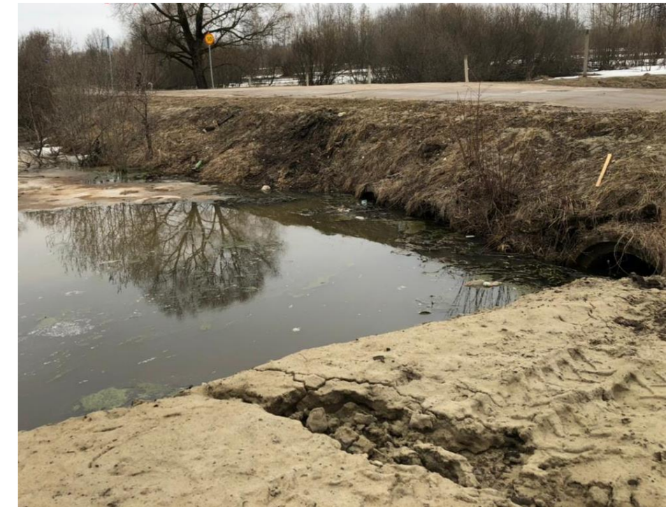
Фото участка дороги по состоянию на 04.2022 г.
