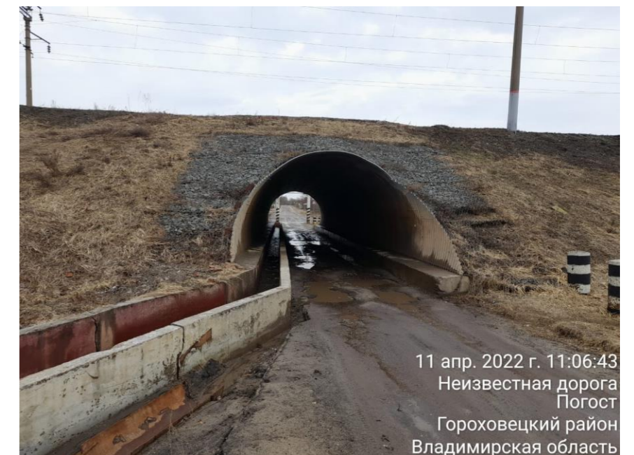
Фото участка дороги по состоянию на 04.2022 г.
