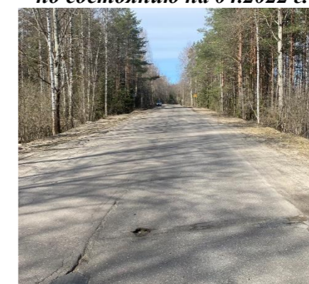
Фото участка дороги № 3 по состоянию на 04.2022 г.
