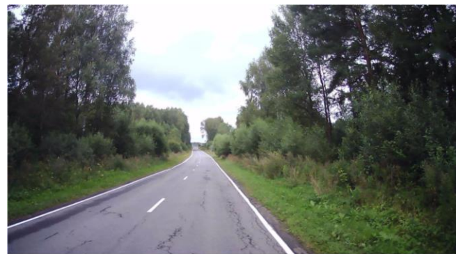
Рис. 4 Продольные трещины
